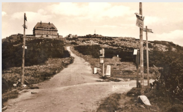
Die Reifträgerbaude um 1930, von Westen gesehen.
